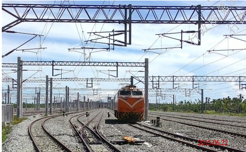
潮州車輛基地電力機車測試軌道、電車線、號誌、通訊、月台設施
