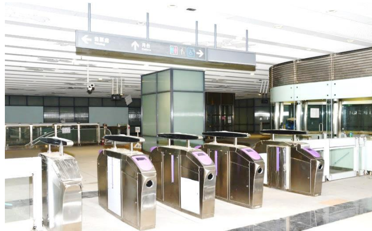
機場第一航廈(A12)站自動收費系統
