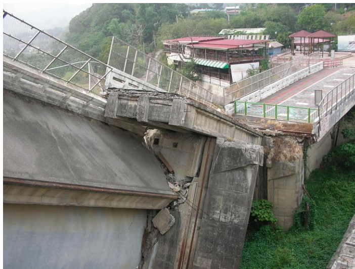
921大地震造成石岡壩溢洪道及閘門斷裂受損之情況
