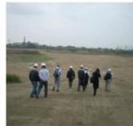
97.4.17 故宮南院工地實況 故宮南院籌建工程停滯不前
